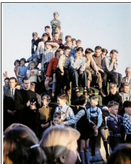
Zaungäste beim ersten Spatenstich
