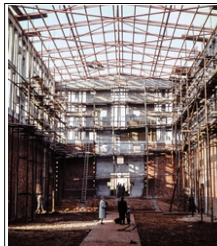
Innenansicht der Kirche mit Gerüstbau.
