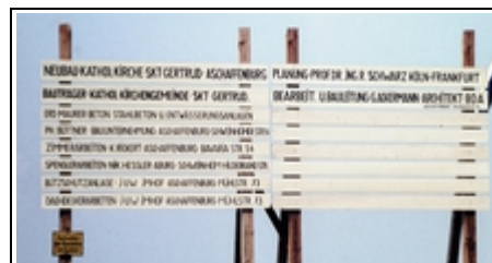
Bautafel mit den aufgeführten Firmen
