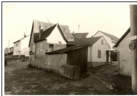
Bahmersgasse, kurz vor dem Abriss der alten Häuser.
