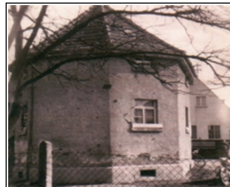
Das Karbidhäuschen in der Ebersbacher Straße
