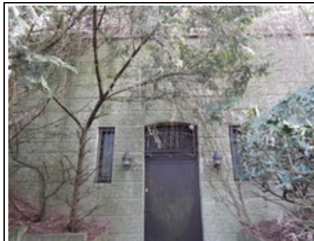
Der Eingangsbereich des Hochbehälters
