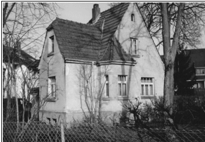
Zustand des Hauses am Sälzerweg kurz vor dem Abriss.
